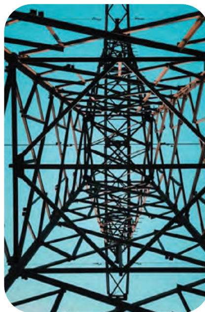
Gambar 4.13.3 Garis Lurus pada Menara Listrik
