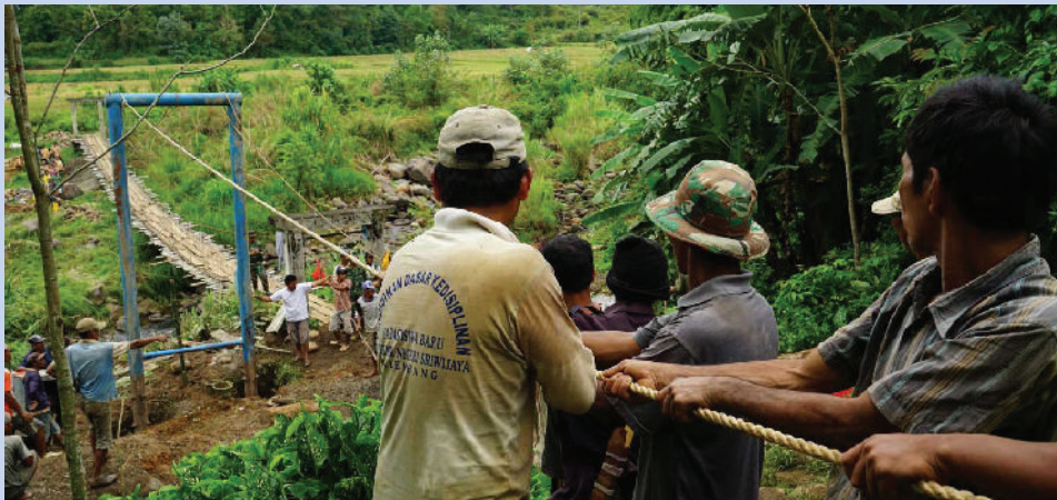
Gambar 5.15 Gotong Royong membangun jembatan
