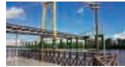
Jembatan Barito Sumber: bartokualakab.go.id
